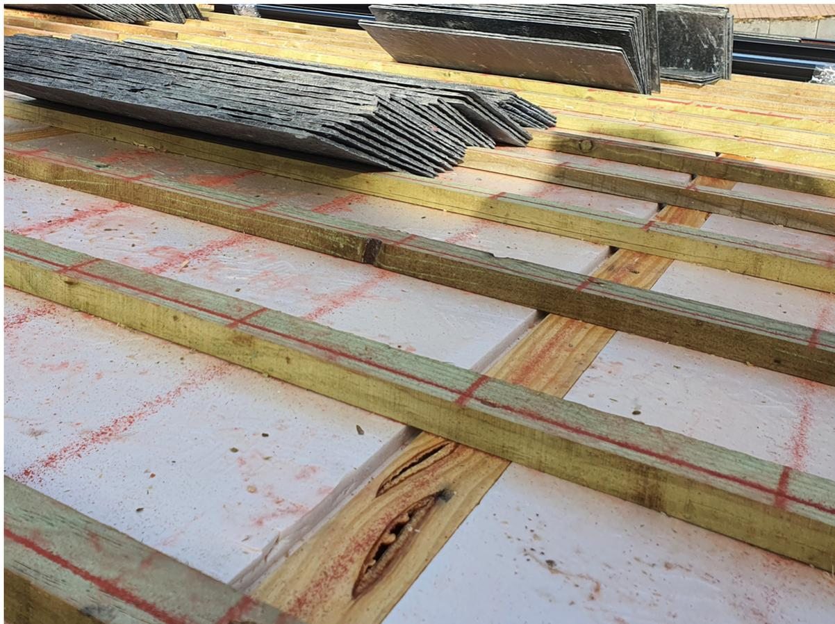
Terminamos entonces la cama de apoyo y replanteamos la colocación de las tejas de pizarra sobre esta. Realizamos marcas verticales con nuestra cuerda tintada con una separación entre ellas igual a la mitad del ancho de una pieza de pizarra. Si la pizarra tiene una anchura de  $22:2=11\text{cm}$  y añadimos otra vez  $0,2\text{cm}$  para el gancho y tenemos **11,2cm** entre cada marca. Una vez marcada toda la cubierta, la colocación del faldón se inicia por su parte inferior por el alero.
